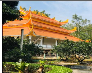
Hình ảnh tại công trình (tính đến tháng 11/2019).
